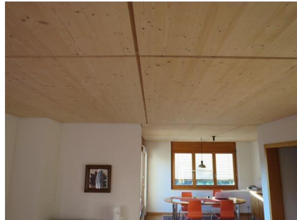
Moderne Deckenverkleidung Fichte massiv
